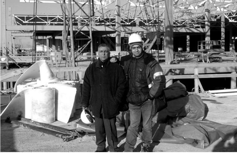
Ben ve Ozan: St. Petersburg'da yapılan IKEA'nın inşaat sahasında
